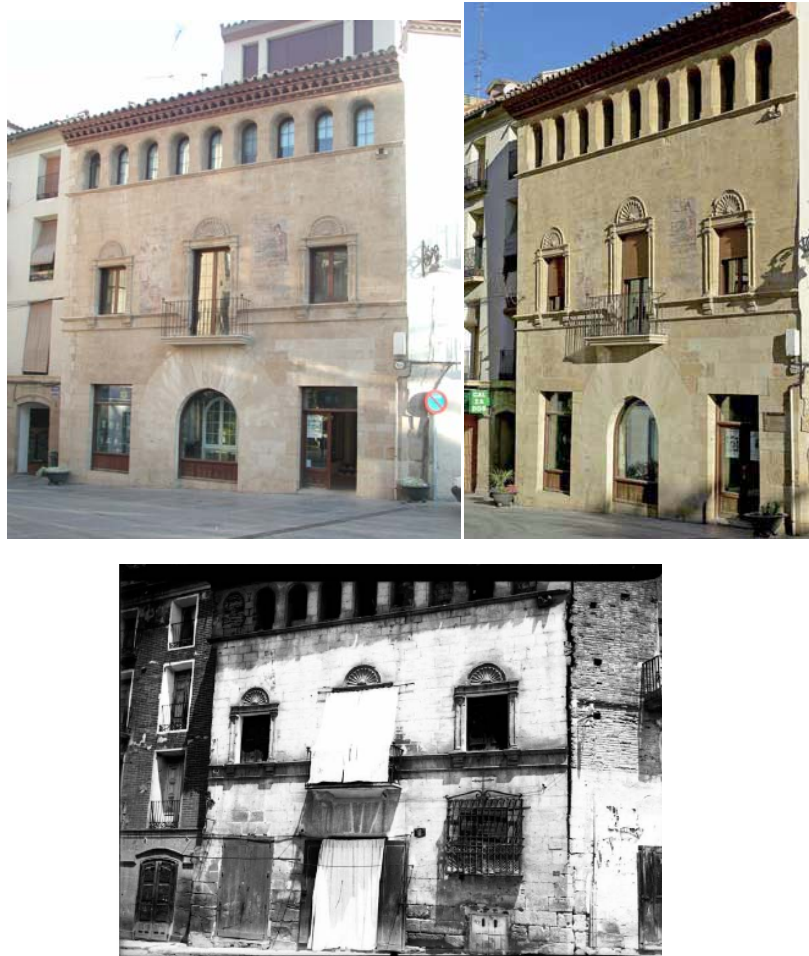
Foto anterior a la rehabilitación
