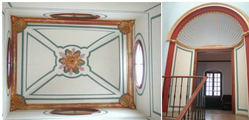
Interiores: techo de la escalera y puerta acceso planta noble
