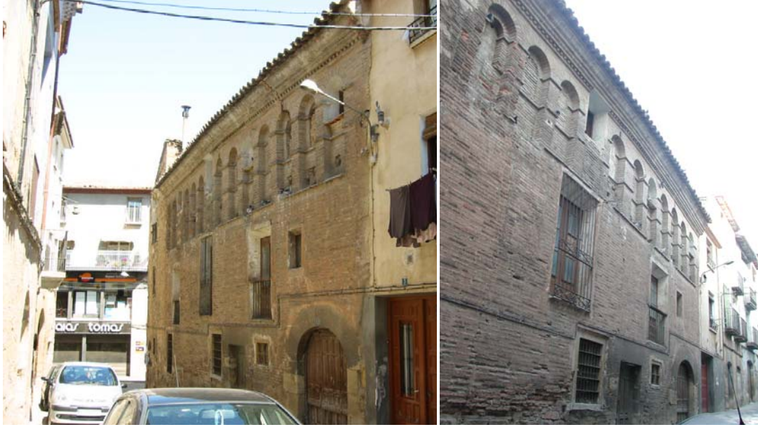
Fachada C/. Alta
