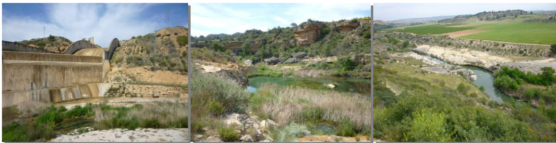
Aspectos del cauce del río Guadalope: escuridero del embalse de Caspe II y Vuelta del Cañar
