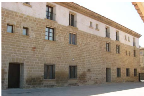
Fachada al patio O
