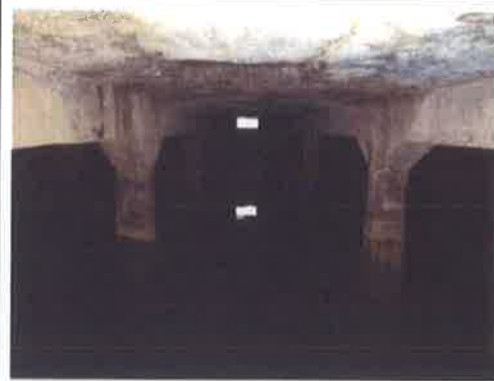
Foto 17.- Vista del interior del depósito " el Castillo"
