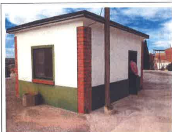
Foto 12.- Caseta de impulsión depósitos de agua tratada
