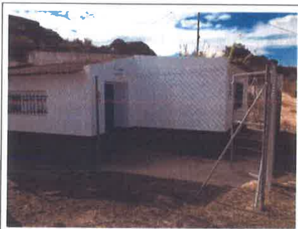
Foto 4.- Toma 3. Caseta de llaves.
