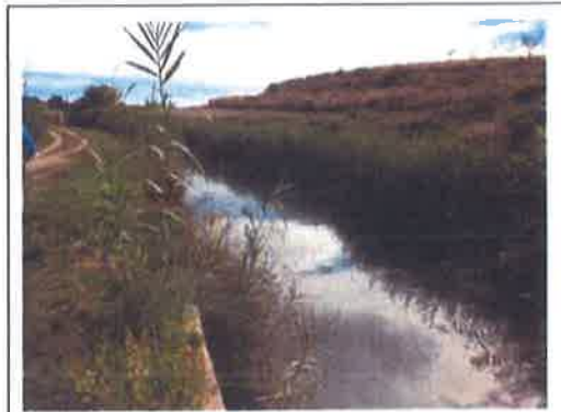
Foto 1 . Toma 1.- Acequia principal de Civan
