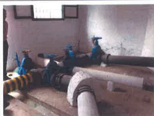
Foto 14 y 15.- Detalle de las instalaciones del equipo de impulsión al depósito del Polígono El Castillo.
