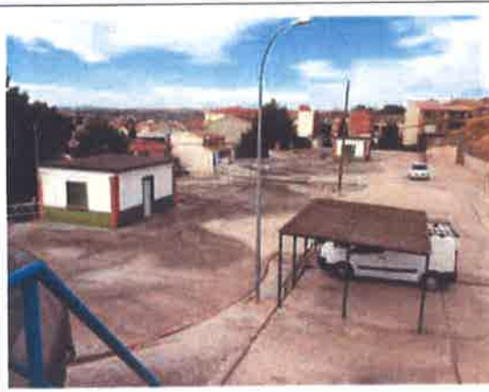
Foto 13.- Emplazamiento depósitos de agua tratada enterrados
